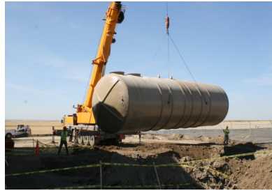
Tioga Lodge WWTP
